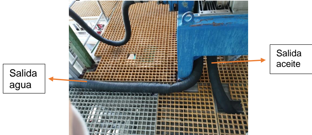
Figura 31 . Ductos salidas subproductos
