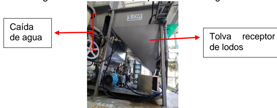
Figura 21 . Tolva lodo; separación lodo-agua
