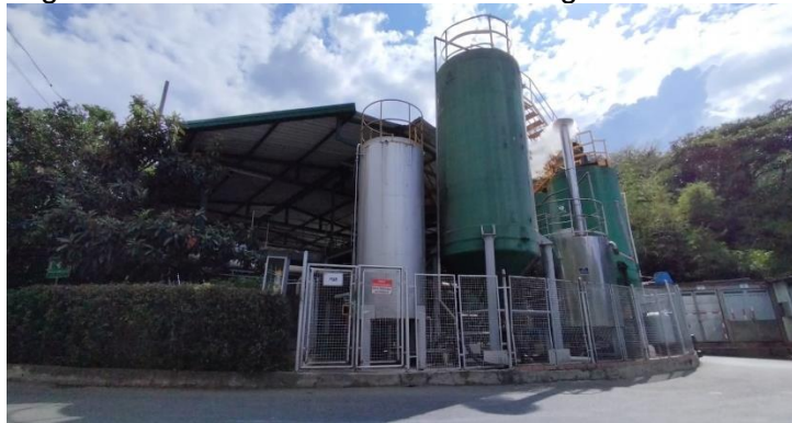
Figura 2 . Planta de Tratamiento de Aguas Residuales
