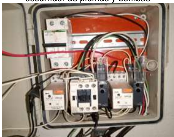
Ilustración 12. componentes para el escurridor de plumas y bombas
