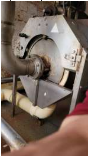
Ilustración 9. parte donde llega la pluma transportada por las bombas
