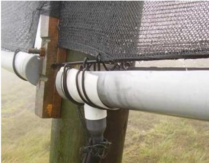
Imagen 2. Detalle de Condensación de gotas a canaleta [7]
