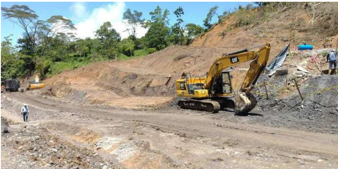
Figura 4. Inicio de la obra
