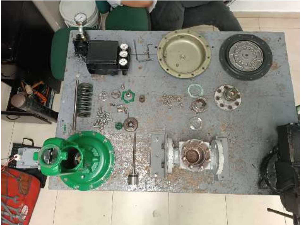
Figura 47 Mantenimiento preventivo a Válvulas de control.
