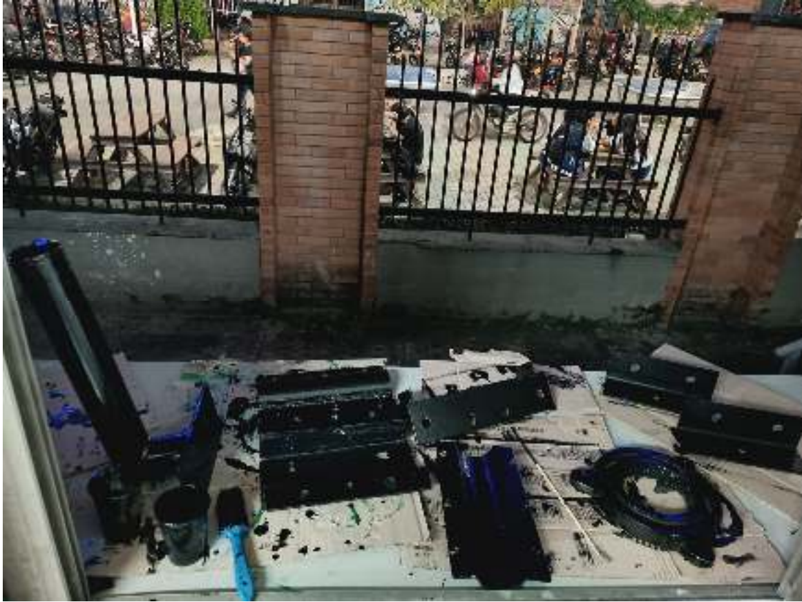
Figura 50 Intervención para pinar los soportes de las válvulas y prensa.
