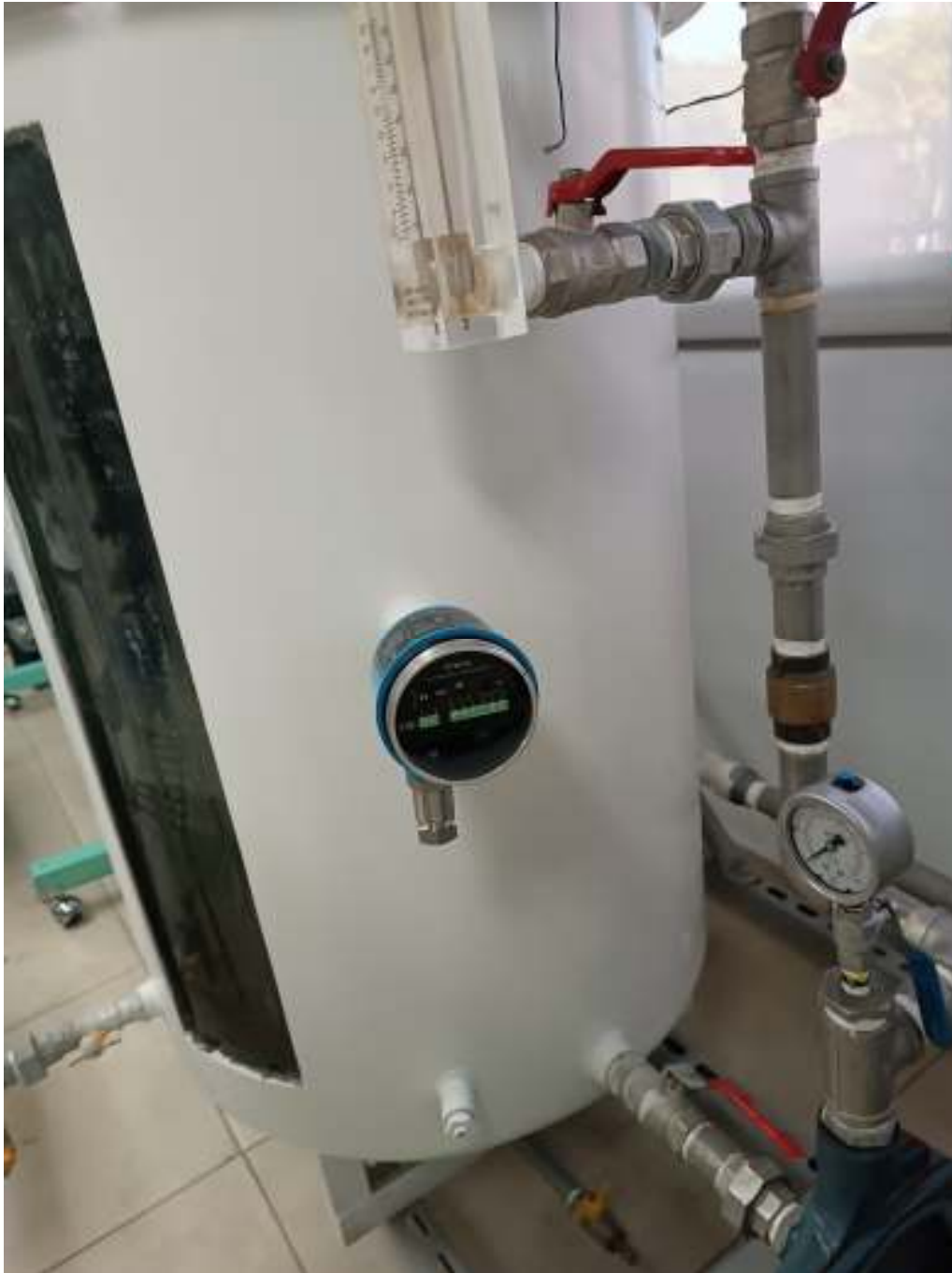
Figura 27 Sensor de nivel de paletas vibratorias.
