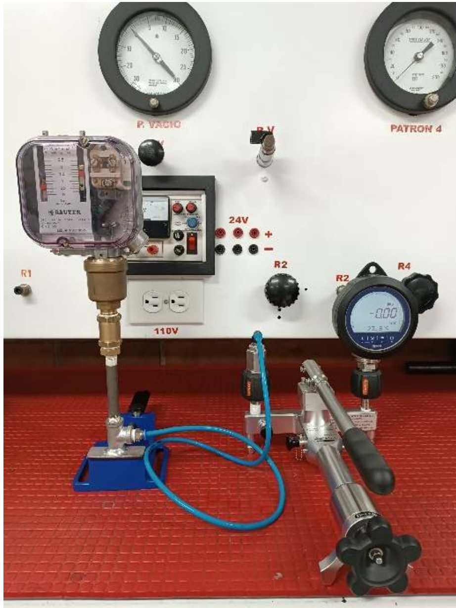
Figura 33 Mantenimiento preventivo a presostatos.
