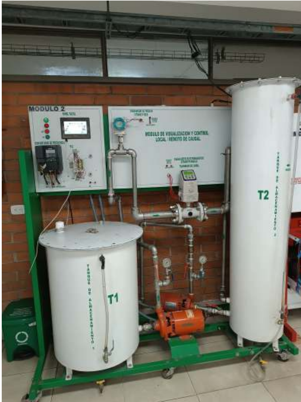
Figura 16 Modulo 2 de control remota de caudal.
