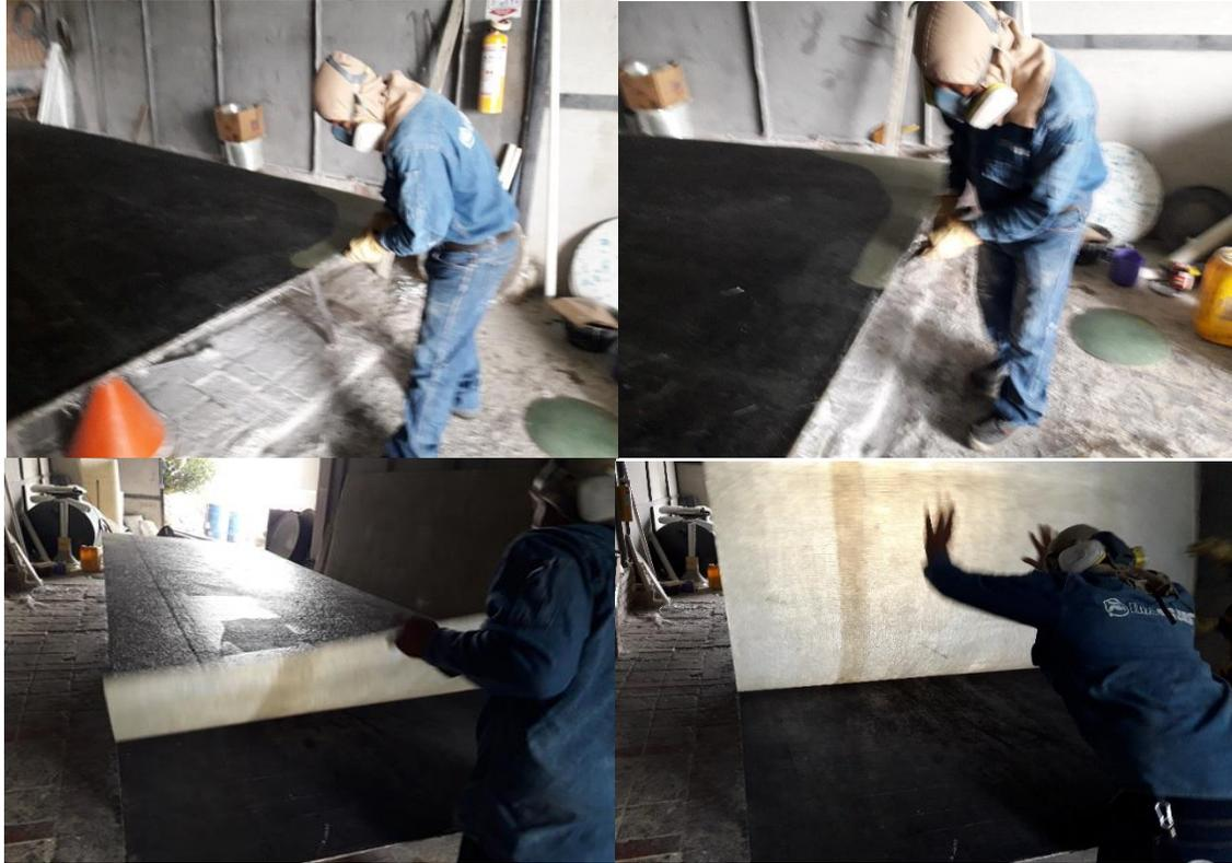
Figura 3. Medicion y corte de la lamina de fibra de vidrio
