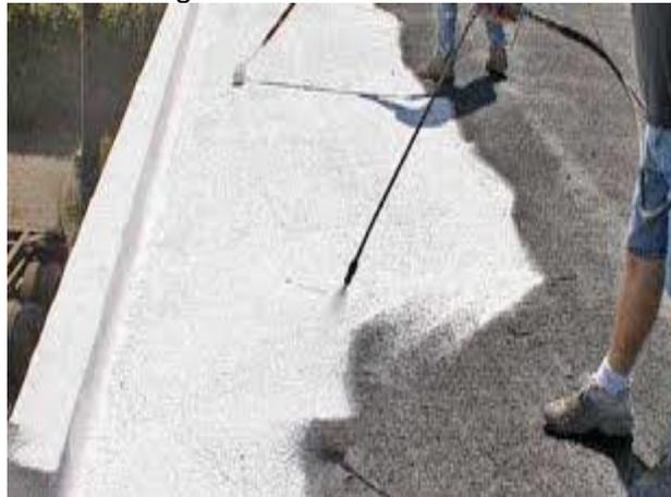
Ventajas de la pintura fibrocemento: Ignífuga (no transmite el fuego). Alta resistencia a la intemperie. No se descascara ni se embomba. Alta resistencia a la lluvia ácida. No requiere sellamiento por la cara opuesta de la teja. El color blanco disminuye la temperatura interior en ambientes cálidos. Bajo Compuesto orgánico volátil. No lo atacan los rayos UV, no se decolora con el tiempo. Amigable con el medio ambiente.
