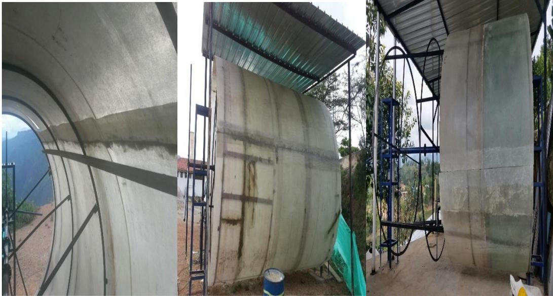
Figura 10. Puesta de la resina sobre la estructura del tanque
