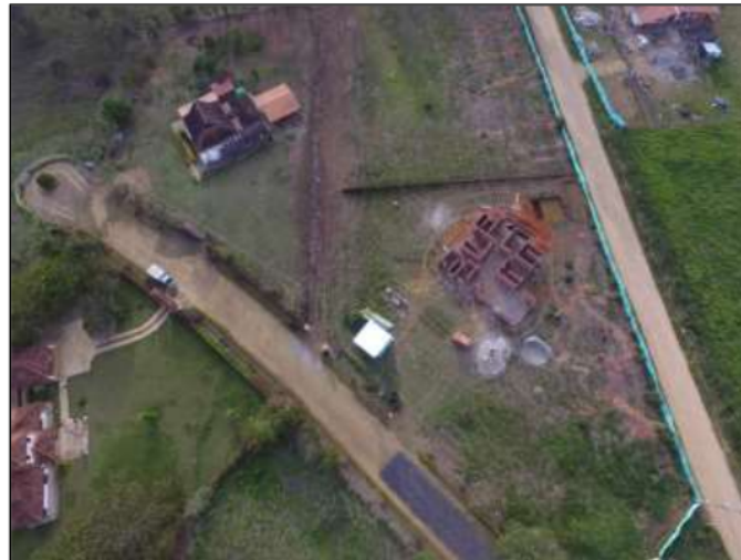
Figura 10. Sobrevuelo con dron marca DJI en el predio vista 1
