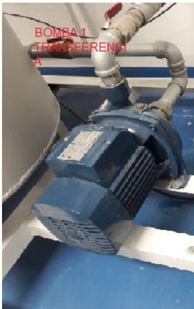
Fig. 10. Bomba centrífuga Pedrollo Cp620 – 1Hp
