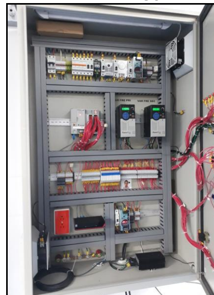
Fig. 7. Tablero de control del sistema de riego
