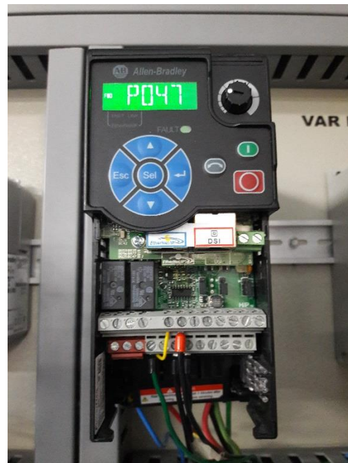
Fig. 9. Variador de frecuencia.
