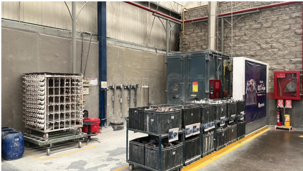
Figura 7 Estado actual de las bases de pintura de línea 1 en el horno de pirólisis
