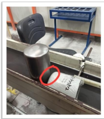
Figura 6. filtro abollado (cadena brinca en movimiento)
