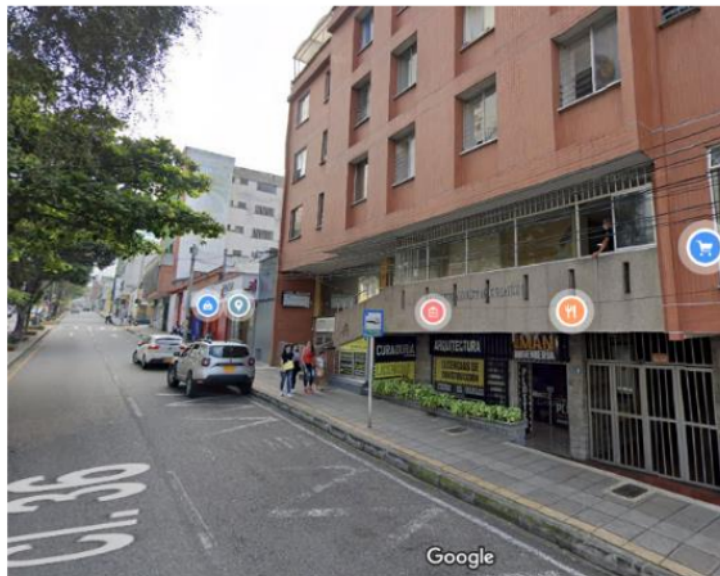
Imagen 3: Edificio Agustín Codazzi (Vista Occidente-Oriente)
