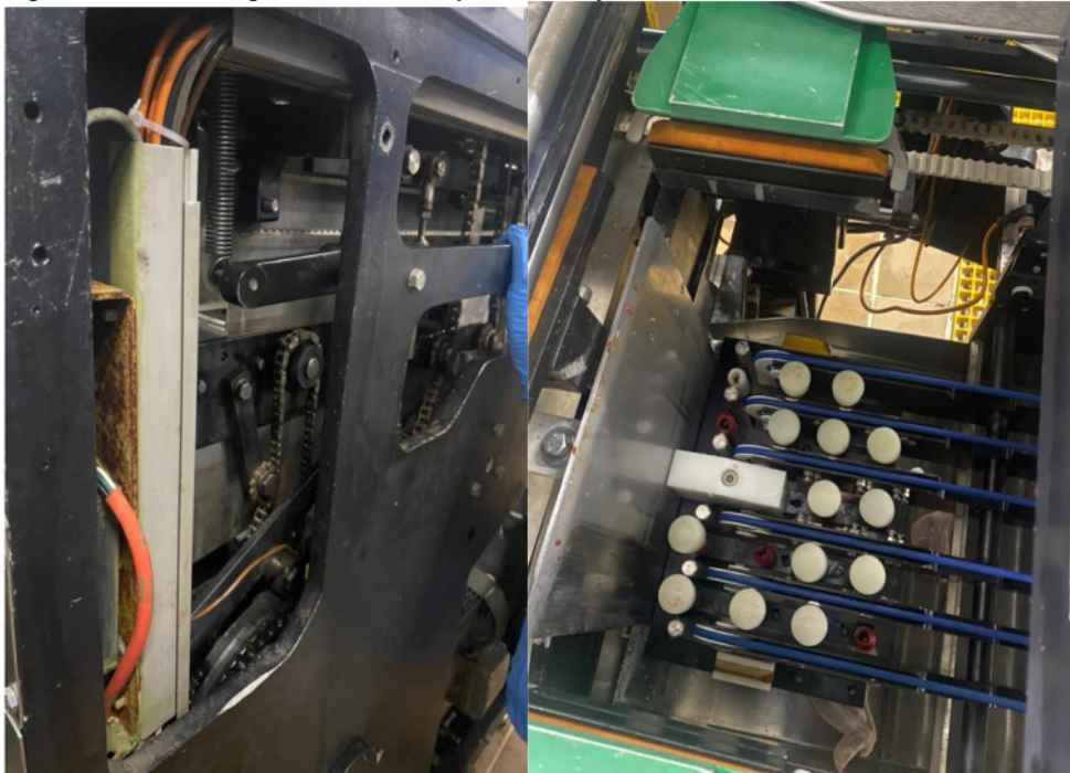
Figura 9 Revisión de ganchos de bandeja a la ulma y funcionamiento de la misma
