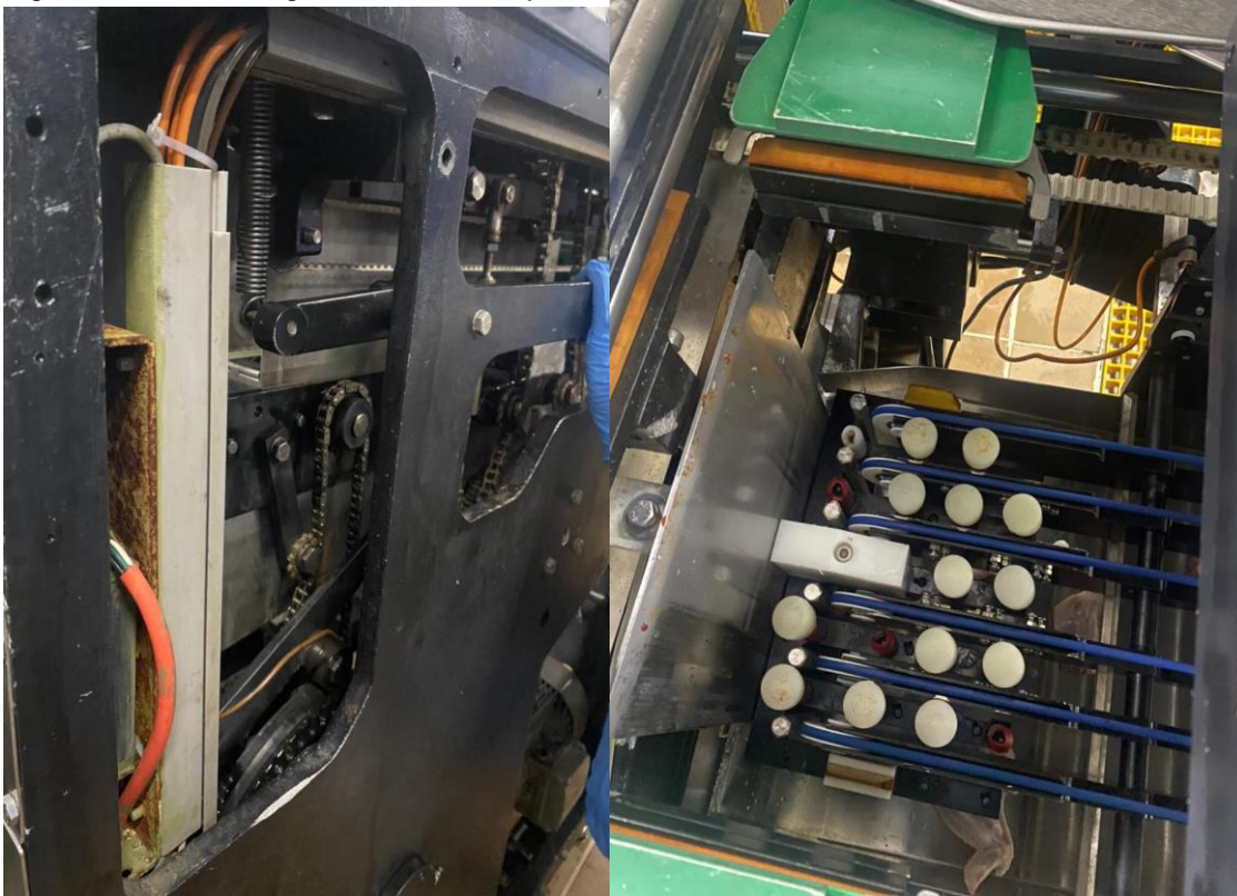
Figura 9 Revisión de ganchos de bandeja a la ulma y funcionamiento de la misma
