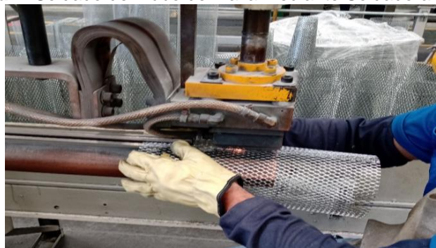
Figura 4. Soldado del Tubo de Malla mediante Soldadora Barra Z
