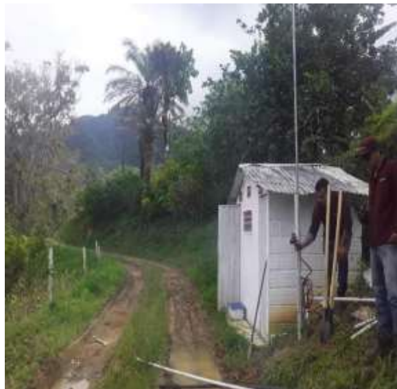
Figura 5. Mantenimiento de arco de desinfección y redes hidráulicas de la granja Amparo
