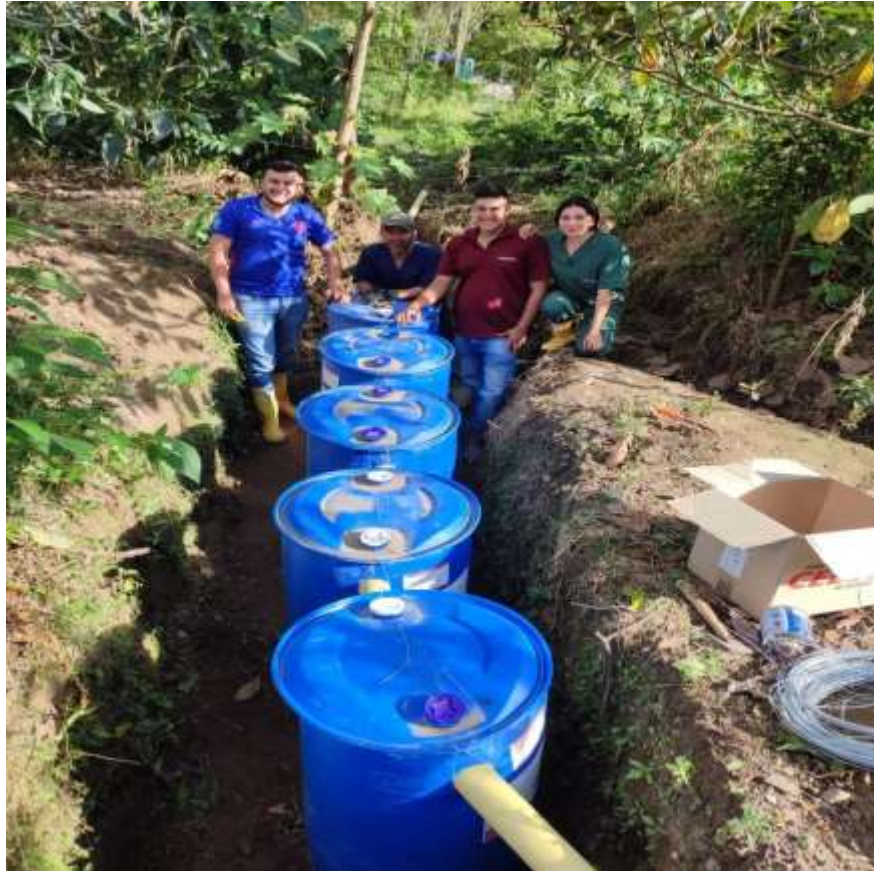
Figura 34. Pozo séptico terminado en la granja la Vega
