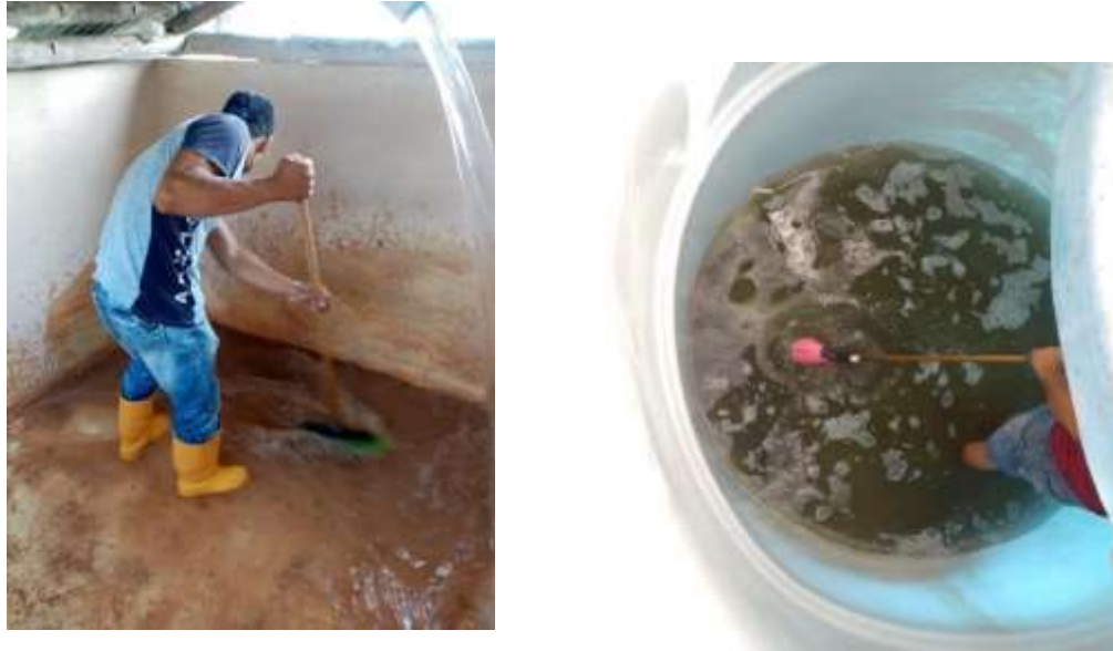
Figura 30. Acompañamiento por parte de operarios de sanidad y coordinación de bioseguridad en lavado de tanques.
