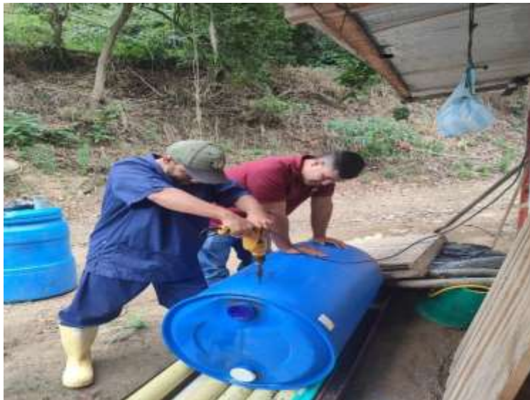
Figura 33. Construcción de pozo séptico a partir de canecas recicladas
