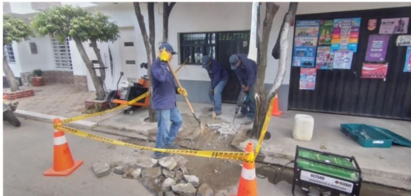
Figura 6. Reestructuración de algunos espacios en malas condiciones
