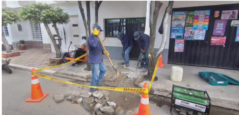
Figura 6. Reestructuración de algunos espacios en malas condiciones
