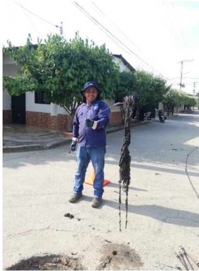
Figura 4. Extracción de desechos de los sistemas
