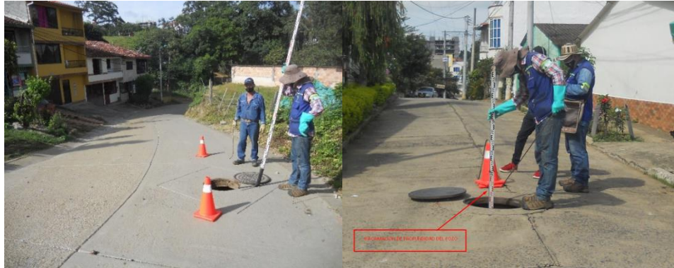
Figura 13. Toma de profundidad de pozos.
