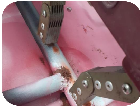
Figura 22. Aplicación de Partículas Magnéticas en unión de soldadura estructura chasis END.
