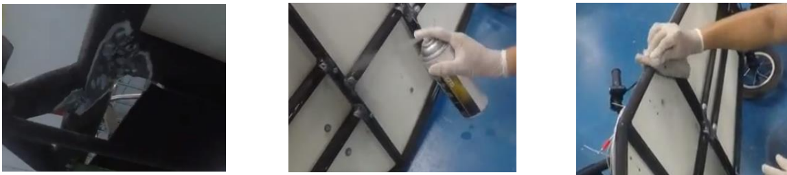
Figura 20. Procedimiento segunda limpieza uniones soldadas.
