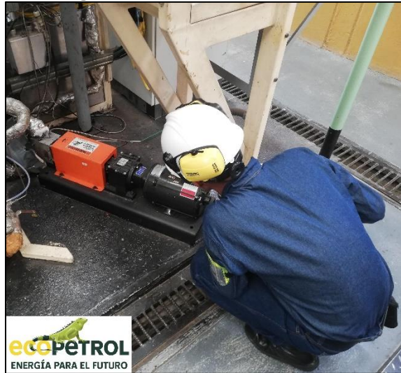
Figura 5. Revisión de la bomba.
