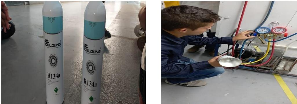
Imagen 12: a) Refrigerante 134<sup>a</sup>; b) carga de refrigerante al equipo
