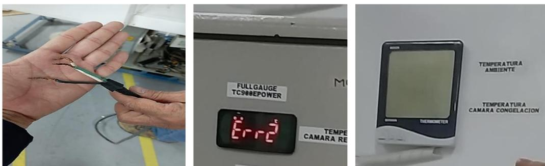
Imagen 1: a) cableado sin enchufe b) falla del tc-900e c) termómetro de la precámara
