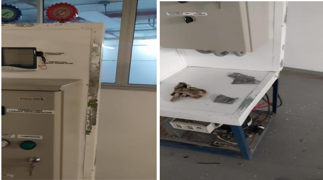
Imagen 15. Proceso de lijado al equipo
