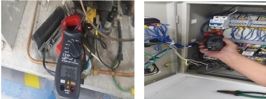
Imagen 6. Medición de corriente del equipo
