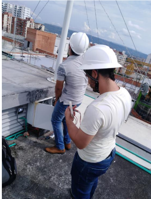
Imagen IV Estudiantes realizando montaje de los circuitos de control de la señal de salida de una turbina eólica.
