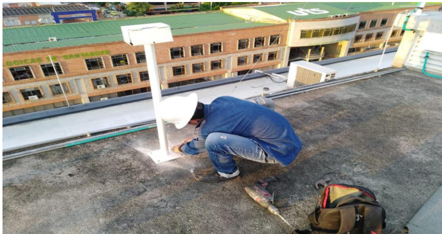
Imagen III Estudiante de electromecanica instalando un pirometro
