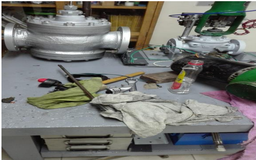
Imagen V: Mantenimientos a las válvulas y partes neumáticas.
