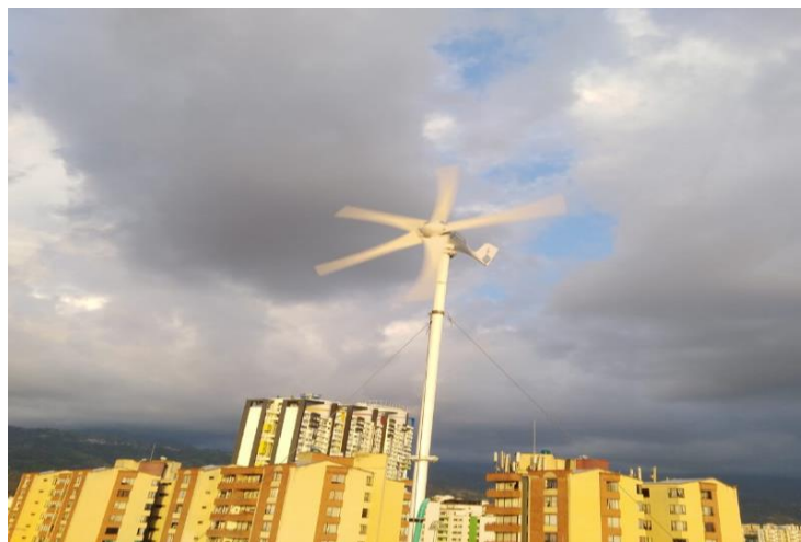
Imagen IV turbina instalada y en funcionamiento
