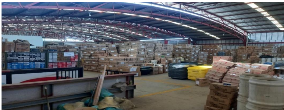
Figura 56 Imagen 2 Bodega Pavco
