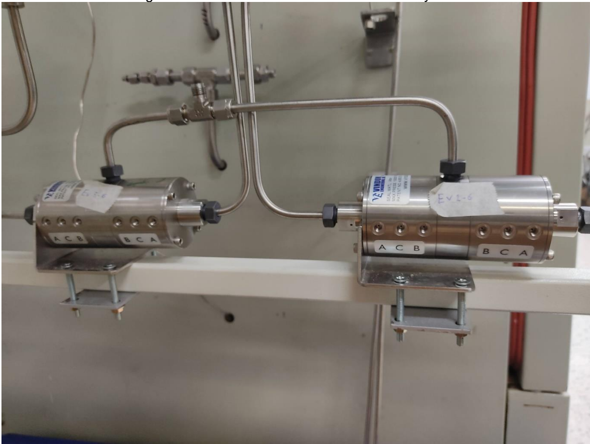
Figura 47 Unión entre las electroválvulas 1-6 y 5-6.
