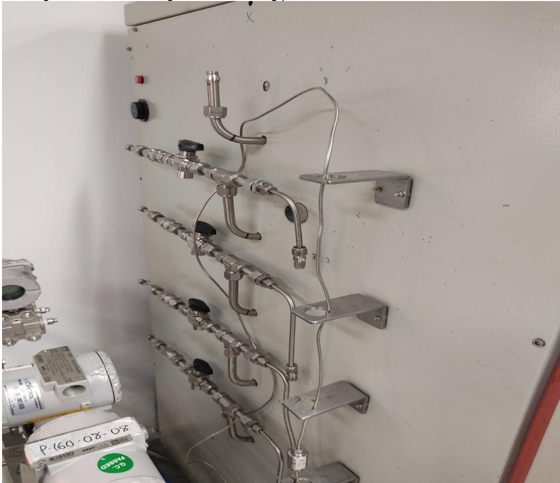
Figura 41 anexo de segmentos de tubing para conexión con el sistema de medición
