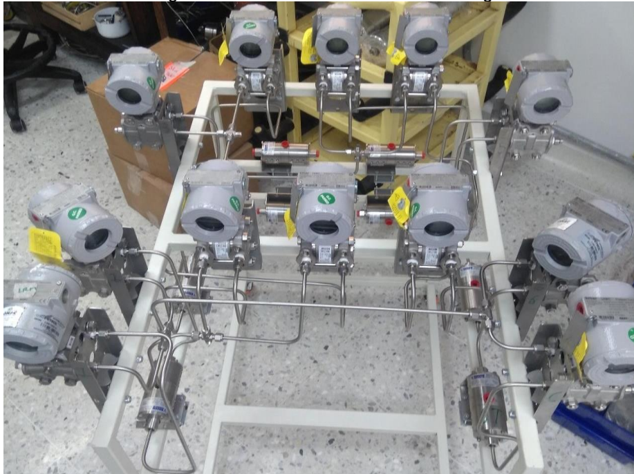
Figura 32 Adecuación de líneas de tubing
