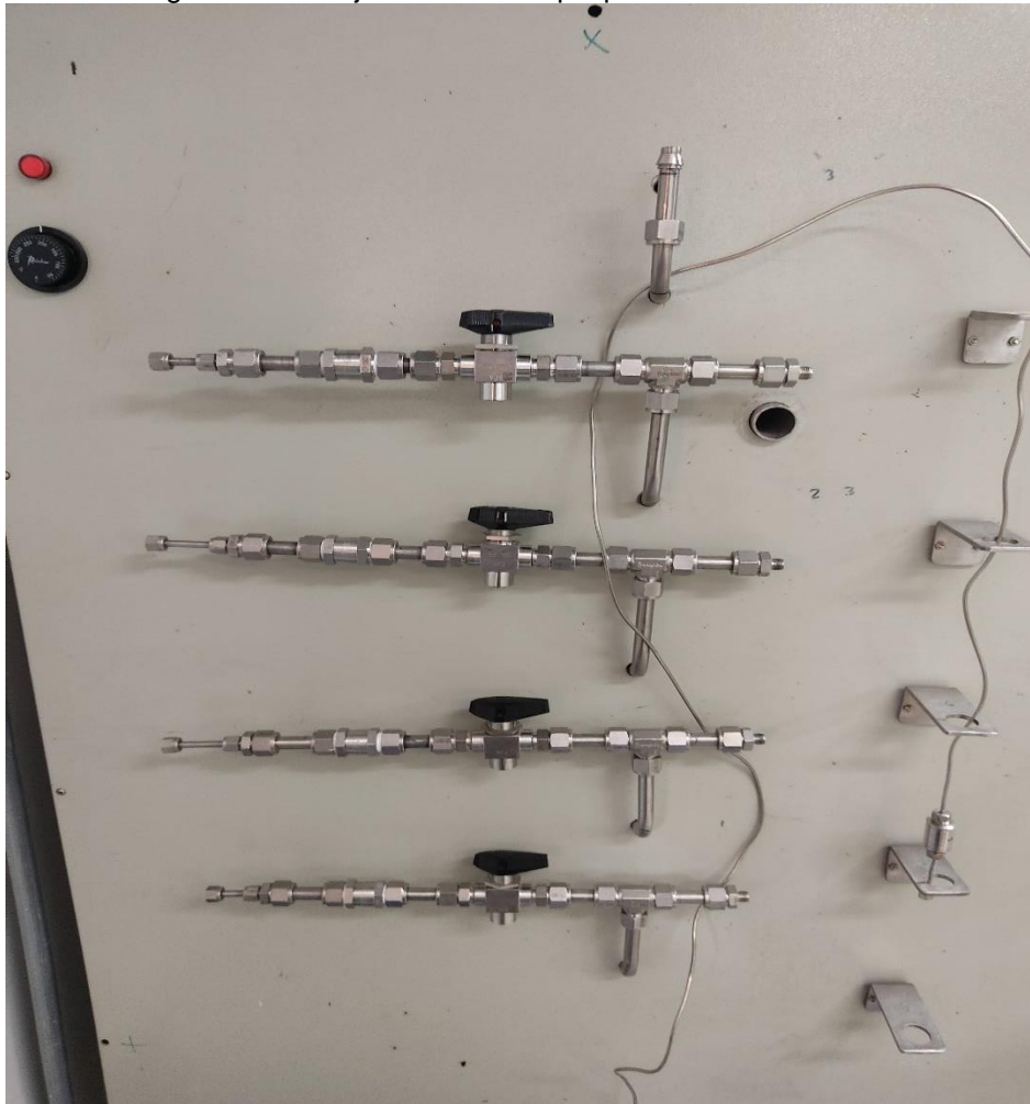
Figura 40 Montaje válvulas cheque para toma de muestras
