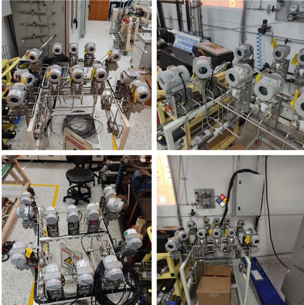
Figura 57 Instalación del sistema eléctrico del Slim tube
